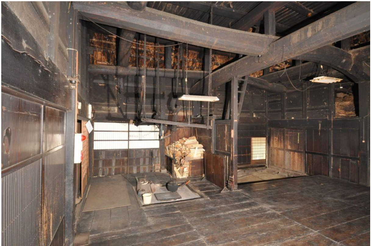
【旧木下家住宅 内部】
