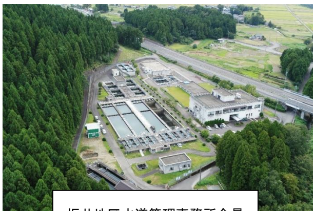
坂井地区水道管理事務所全景
