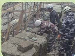
石垣積み直し工事の様子
